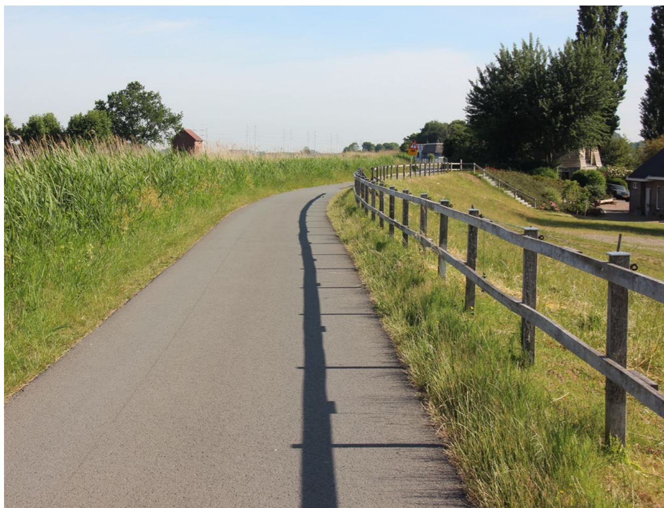
Hekwerk zuidelijk deel Rottedijk
