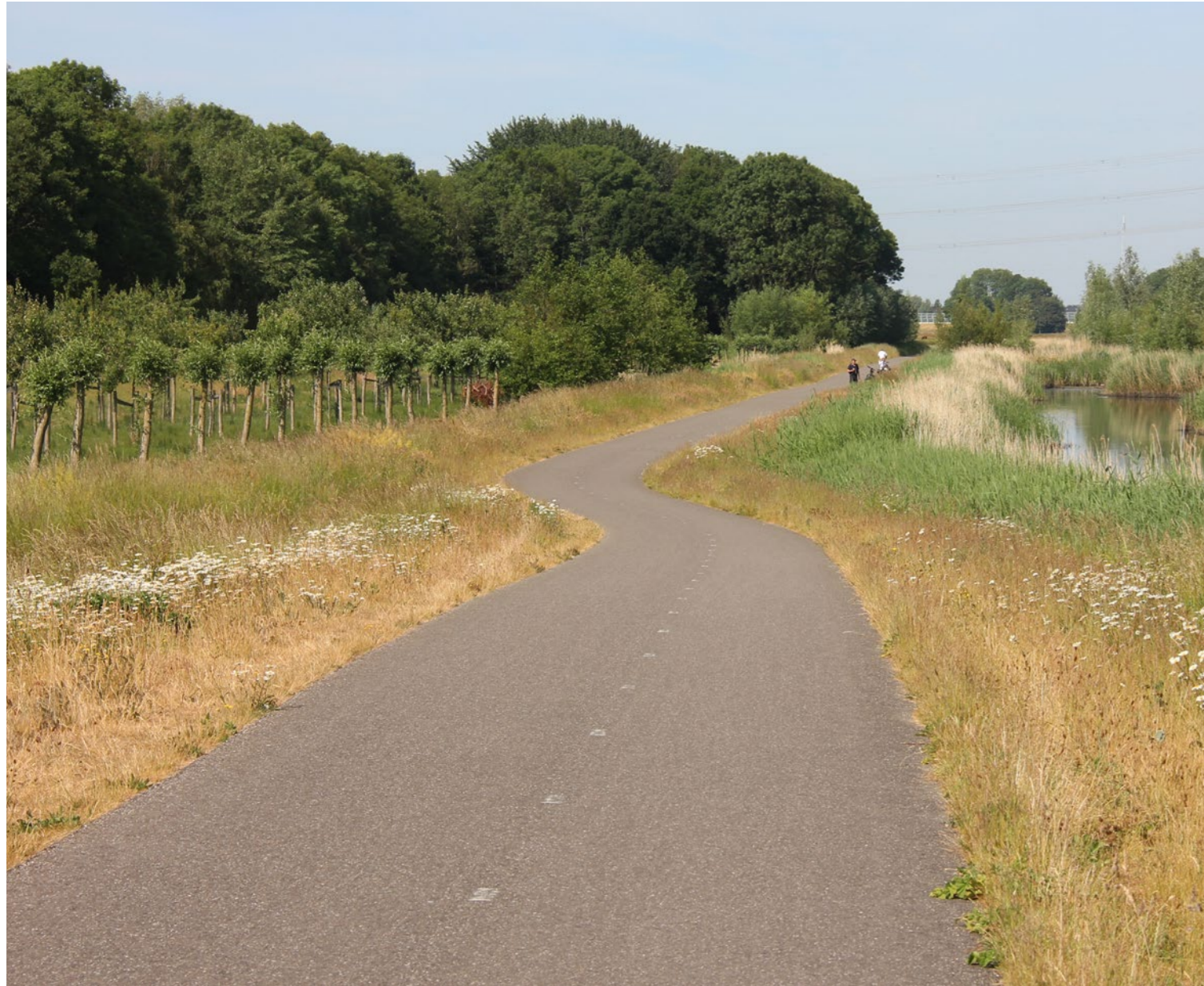
Aansluitend op huidige fietspad met grijs asfalt
