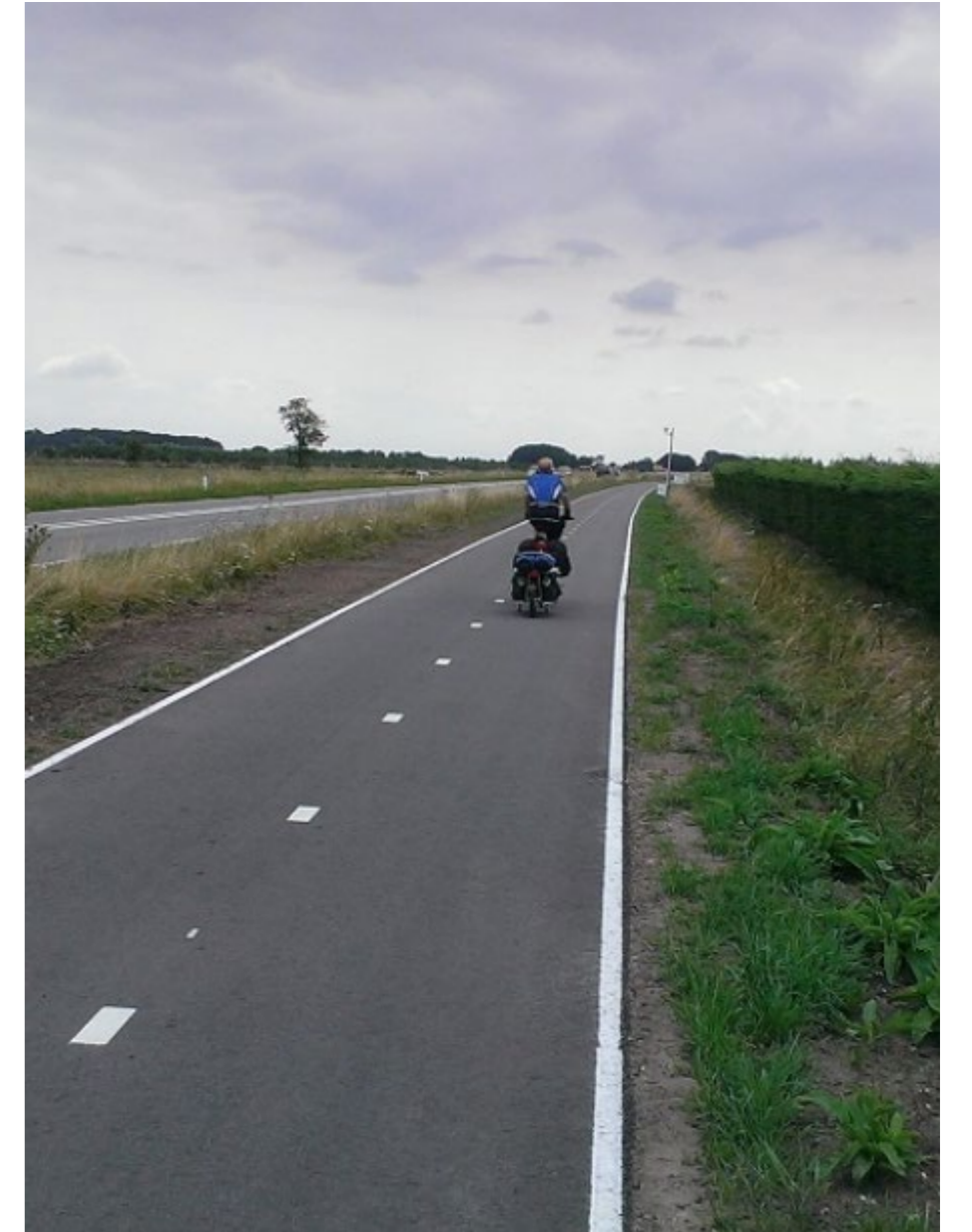
Voorbeeld onderbroken asmarkering en doorgetrokken kantstrepen.
