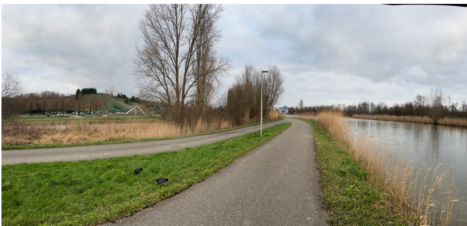
Rottebanbrug en locatie voor voorgenomen realisatie verblijfsplaats aan het water
