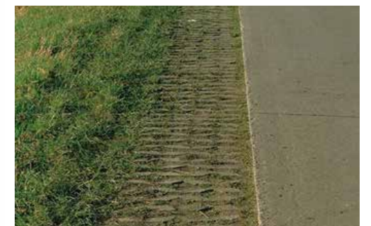
Grasbetontegels (berm + opstelplaatsen ijscowagen en trailer). Eenvoudig en beloopbaar. Bijvoorbeeld: MBI type 6, vlak, vierkante gaten, normaal verkeer, standaard grijs
