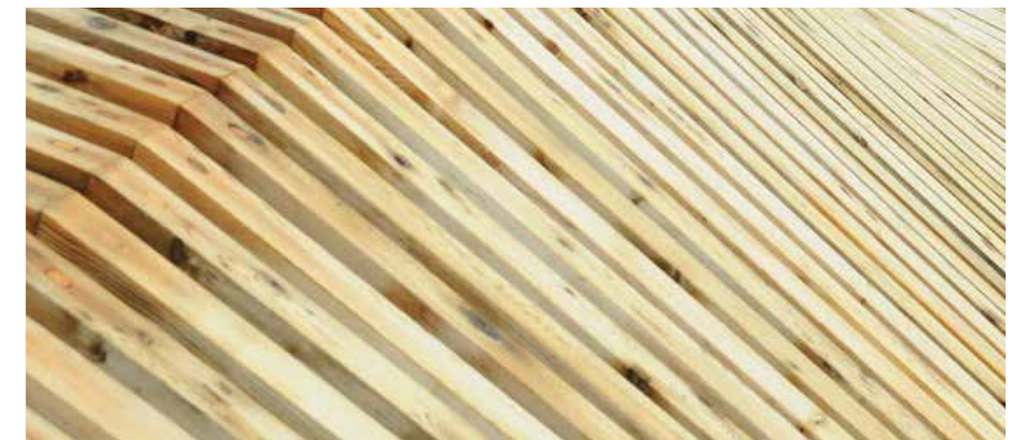
Afwerking: hardhouten planken 60 x 60 mm met 25 mm voeg
