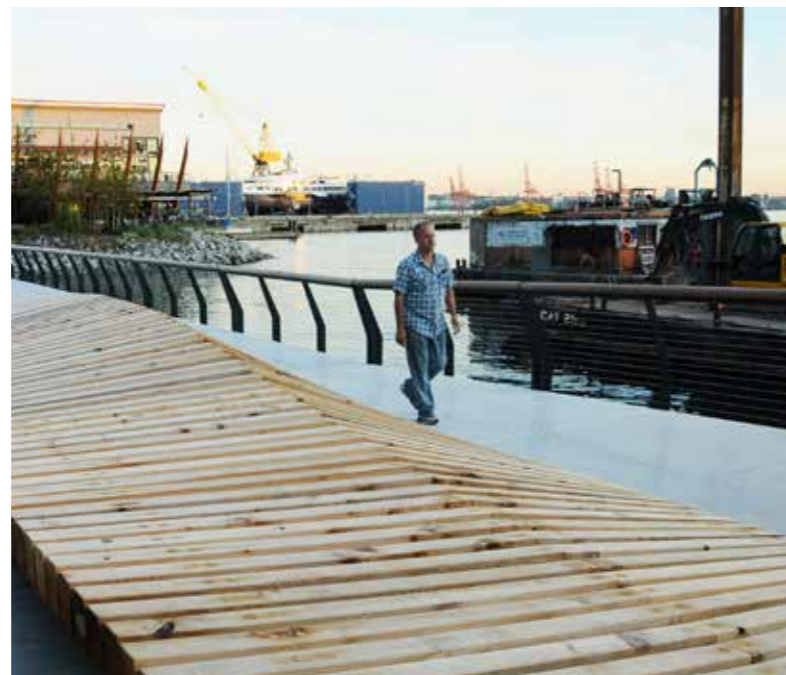
Afwerking: hardhouten planken 60 x 60 mm met 25 mm voeg
