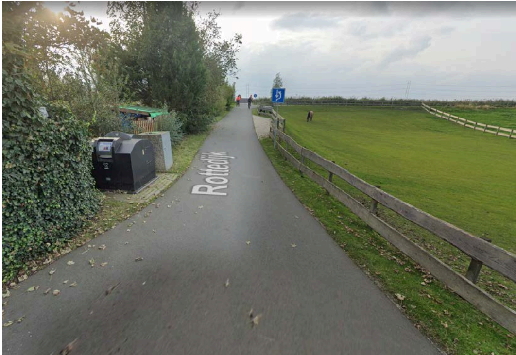
Figuur 3: De Rottedijk tussen Westland en de fietsbrug Rotte, heeft een zeer beperkte breedte van 3.2 m.
