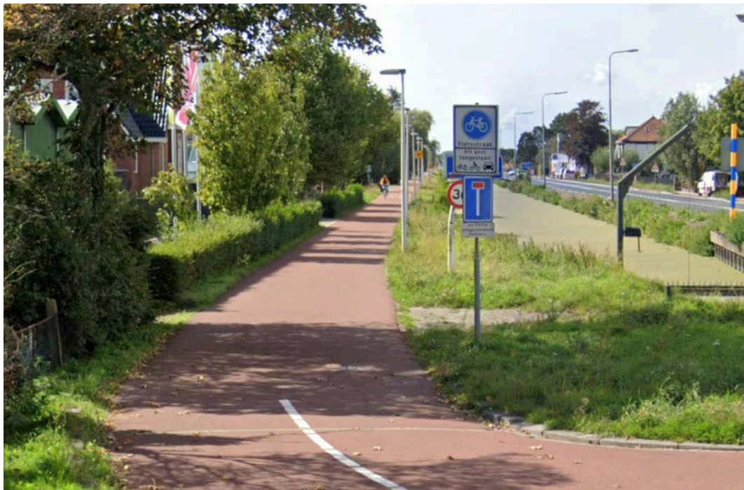
Figuur 5: Fietsstraat buiten de bebouwde kom bij Pijnacker, overlopend in een fietspad na de laatste woning.
