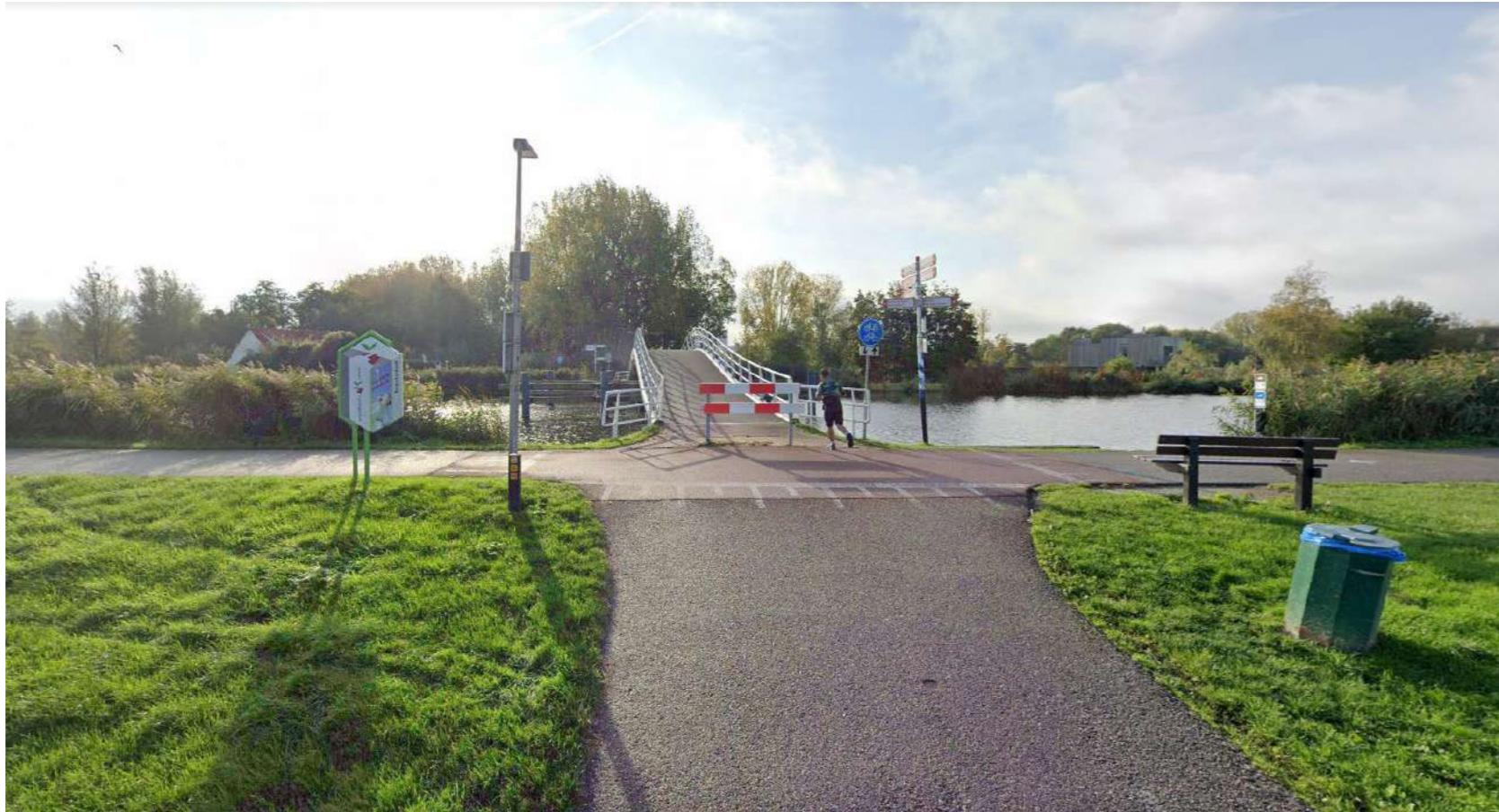
Schrikhek aan voet van de brug verwijderen
