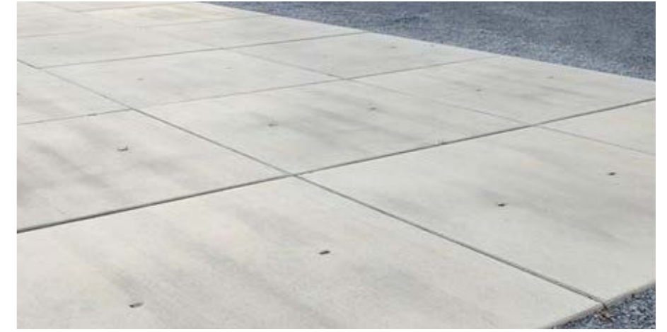
Fundering: Stelcon N-plaat met hoeklijn 1995 x 995 x 25 mm
